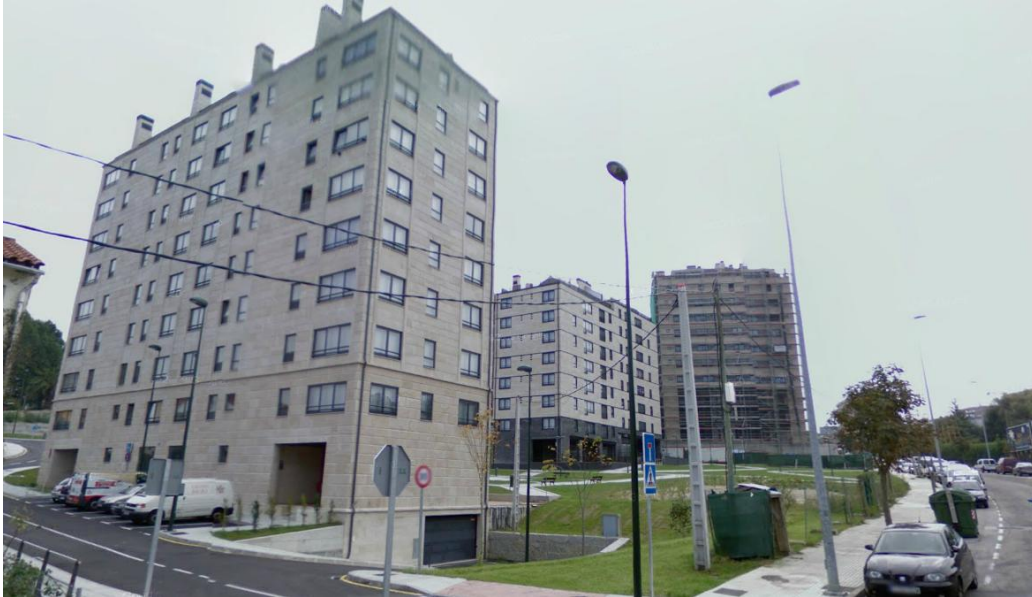
Figura 41 - Urbanización Rocío en la calle Tomás Paredes
