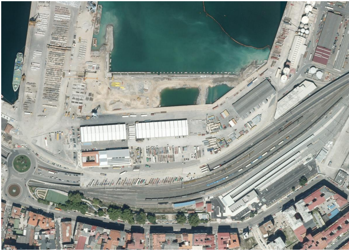
Figura 3 - Vista aérea de la estación provisional de Guixar (fuente: Concello de Vigo)
