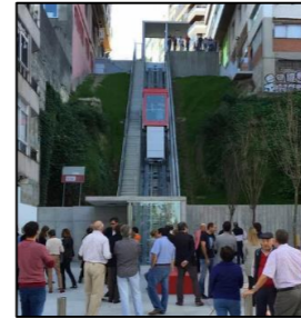
Ascensor inclinado da Av. das Camelias
