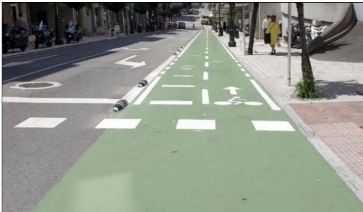
Figura 65: Tramo bidireccional segregado na Rúa Venezuela do novo Carril Bici entre Teis e Samil.
